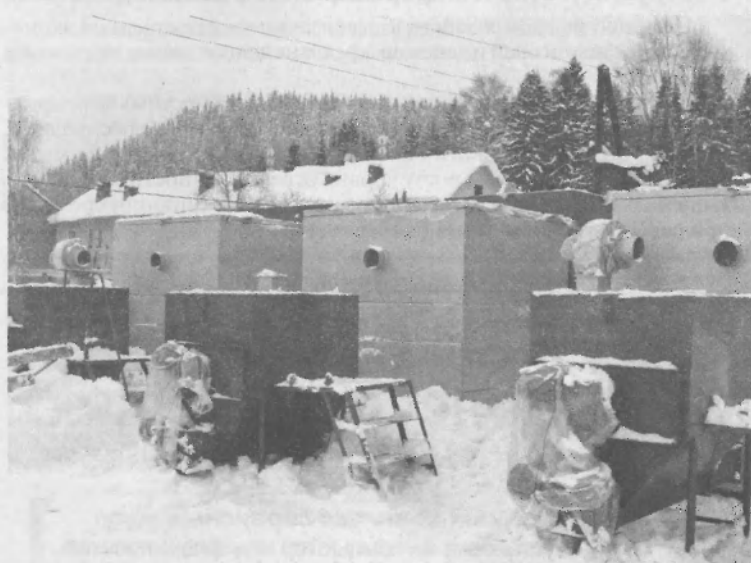
Три новых котла полностью обеспечат поселок теплом
