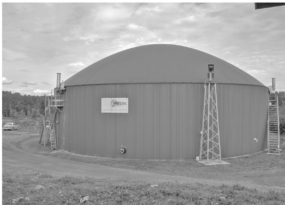
Мусороперерабатывающий комплекс в Финляндии
