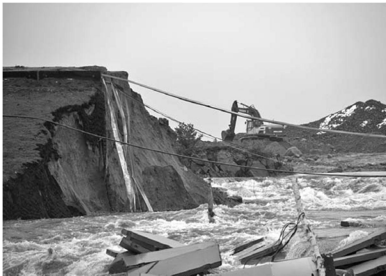
Чуть выше по течению от места размыва дамбы сейчас строят бетонную перемычку
