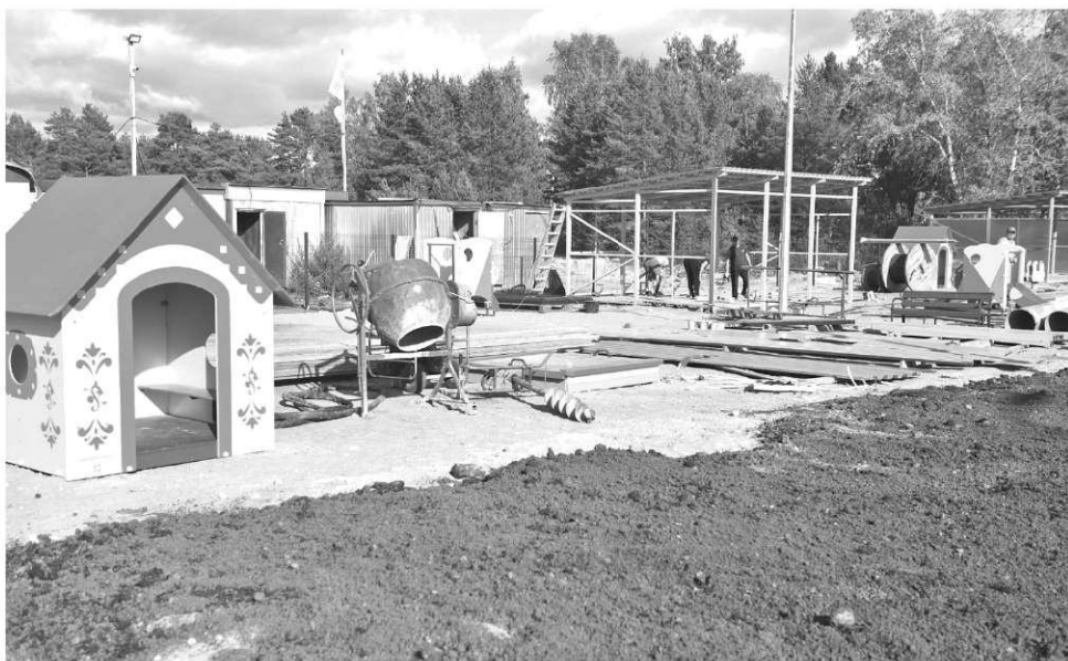
Строительство детского сада
