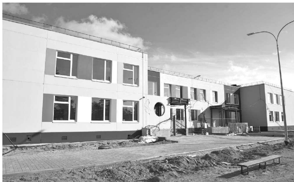
Строительство детского сада в Ильинском
