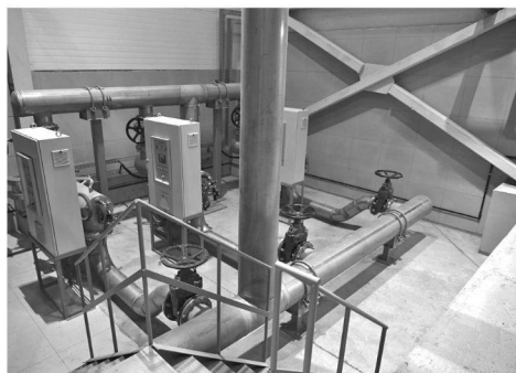
Новые водоочистные сооружения
