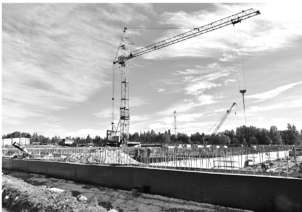
Строительство школы в Кемии
