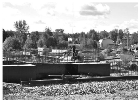
Строительство школы в Кемии
