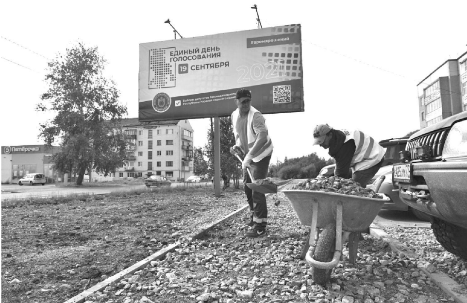
Ремонт тротуаров в Беломорске
