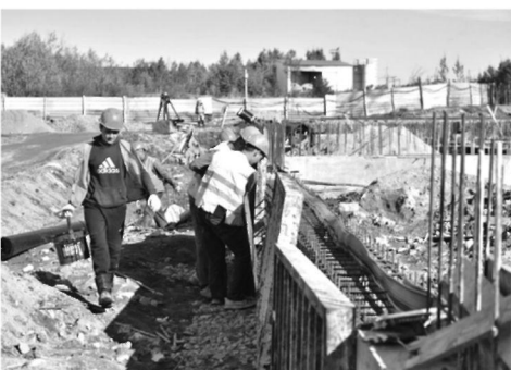
Строительство школы в Кемии
