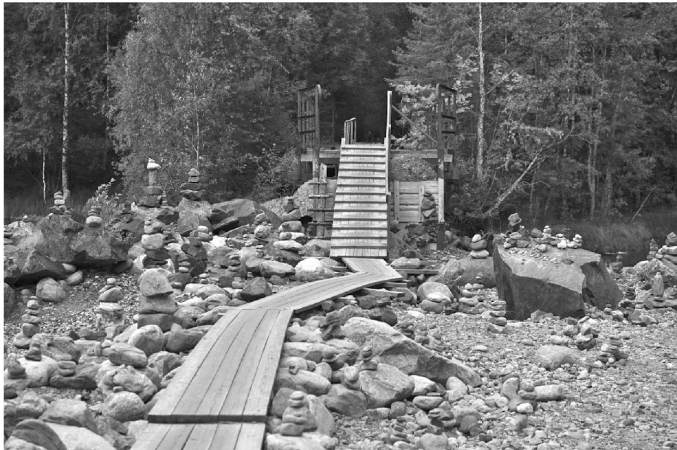
Мост через Кислый Пудас
