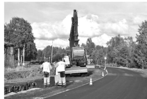
Ремонт подъезда к Кемии
